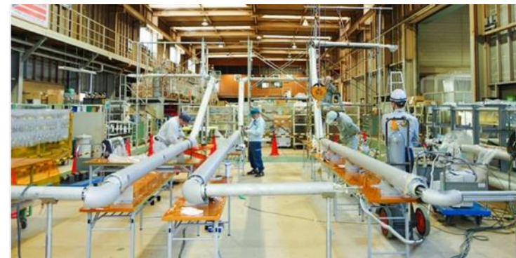
<特殊配管施工風景>
